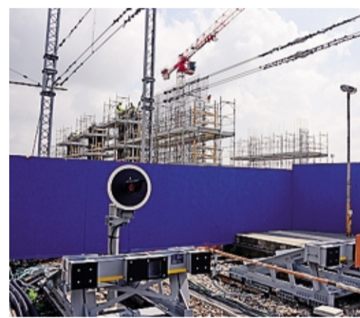
Il ponte ovest della nuova stazione si sta alzando
